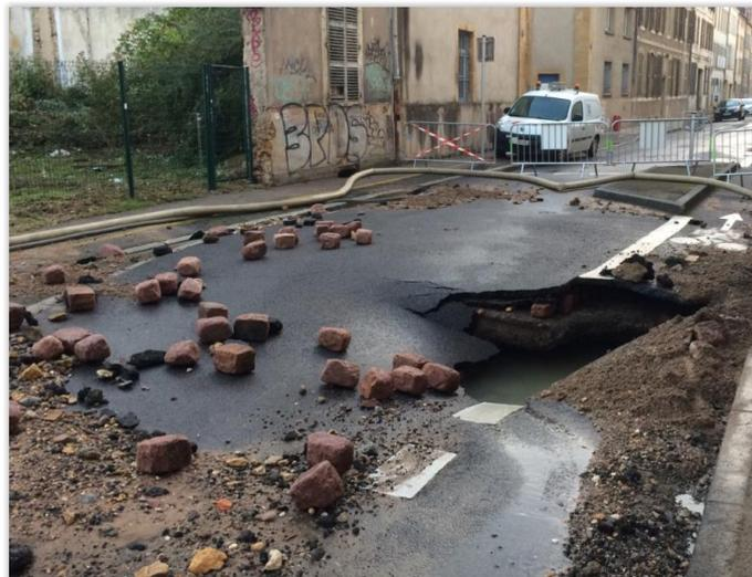
◆ Richemont, à proximité des voies SNCF : rupture canalisation DN 400 le 5 décembre 2018
