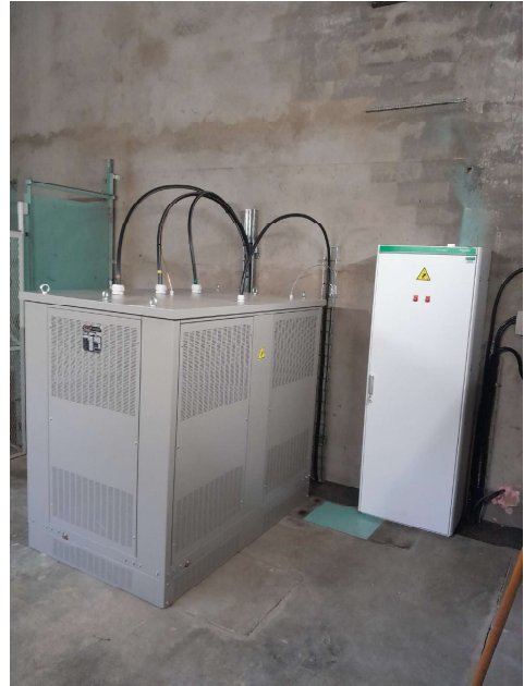
Nouvelle armoire électrique
