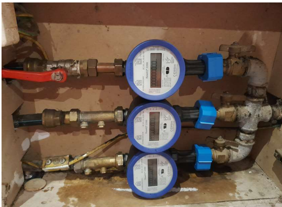
Remplacement d'un bloc de 3 compteurs ABB par 3 compteurs Kamstrup
