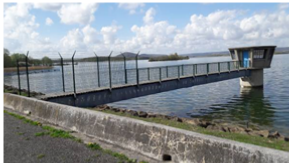
Prise d'eau au niveau de la digue de Marmont (Madine)
