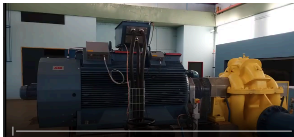
Nouveau moteur et pompe rénovée
