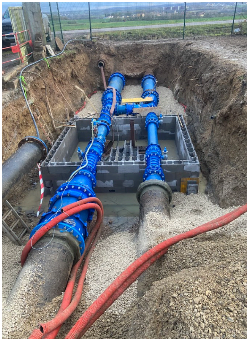
Regard de sectorisation du réservoir de Grimont
