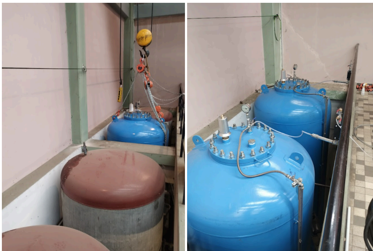
Remplacement des ballons anti béliers de l'usine
